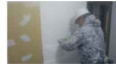
■クロス貼り施工状況
