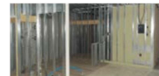
■LGS造作工事 (完了)
