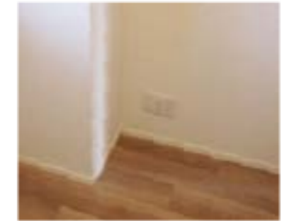
■専有部マルチメディアコンセント取付
