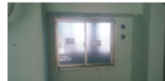
■吹付工事 (完了)
