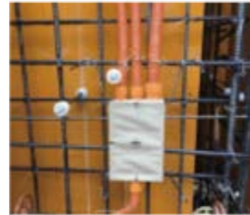
■共用部電気設備用ボックス取付
