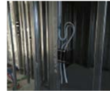
■専有部電気設備用ボックス取付
