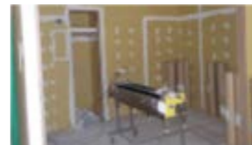
■クロス下地パテ処理状況
