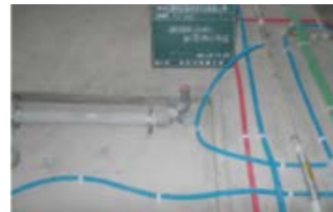
■給排水転がし配管
