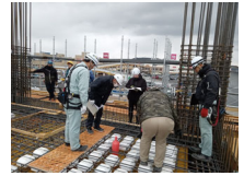
■建築確認中間検査
