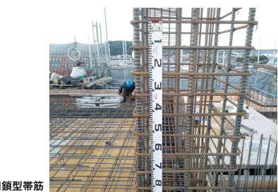
■溶接閉鎖型帯筋
