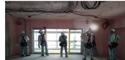
■吹付工事（検査状況）
