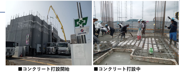
■コンクリート打設開始
