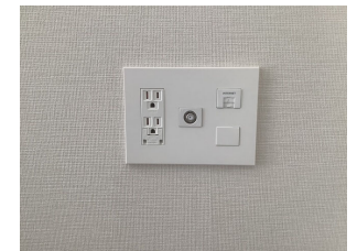
■専有部マルチメディアコンセント取付
