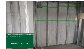
■遮音壁ガラスウール施工
