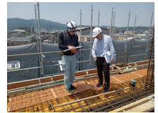
■性能評価機関配筋検査
