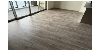
■フローリング完了
