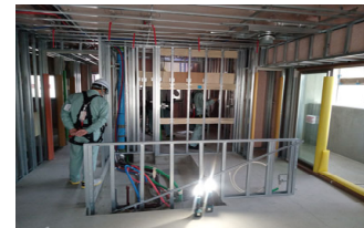
■LGS造作工事
