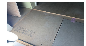
■置床施工状況
