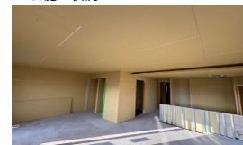
■ボード施工状況
